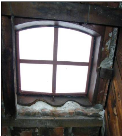
Oprindelige tagvinduer af støbejern.
