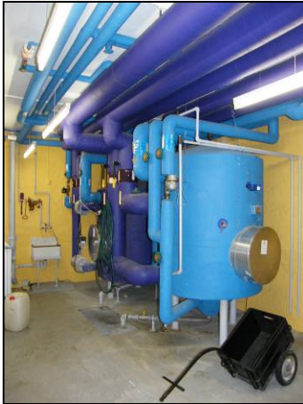
Varmtvandsbeholdere.
