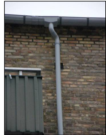
Tilslutning mellem tagrende og nedløb udført af plast.
