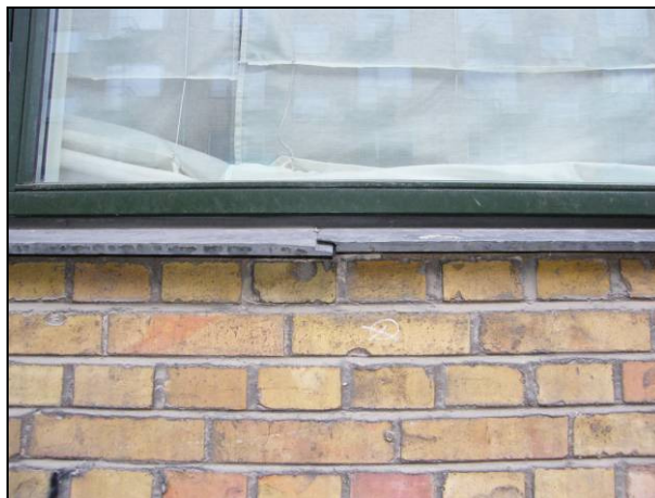
Sålbænk af skifer mod Stærevej med skade ved samling.
