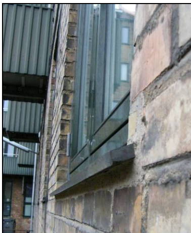
Sålbænk mod baggård med et minimums-fremspring.
