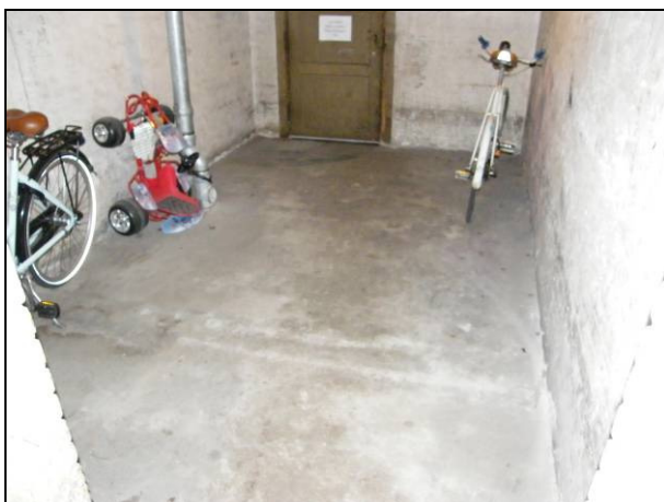
Generelt er terrændækket i pæn og velholdt stand uden revnedannelser og skader.
